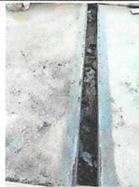
FOTO No. 10 SE CONSTRUYE UNA CUNETA PARA LA RECOLECCIÓN DEL AGUA PLUVIAL DONDE LLEVARÁ UNA REJILLA DE METAL
