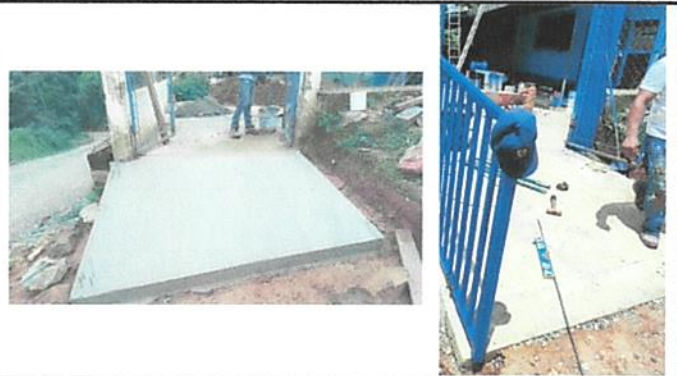
FOTO No. 8 SE TRABAJA EN LA FUNDICIÓN Y TALLADO DE LA RAMPA DE ACCESO A LA ESCUELA
