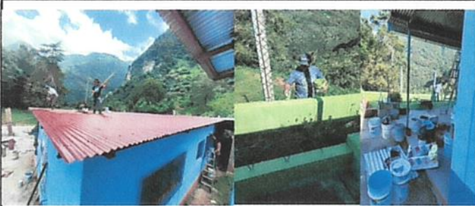
FOTO No. 9 SE REALIZA LA APLICACIÓN DE PINTURA EN MUROS, TAMBIÉN SE APLICA PINTURA DE ACEITE EN EL TECHO DE LAS AULAS PARA PROTECCIÓN DE LA LÁMINA
